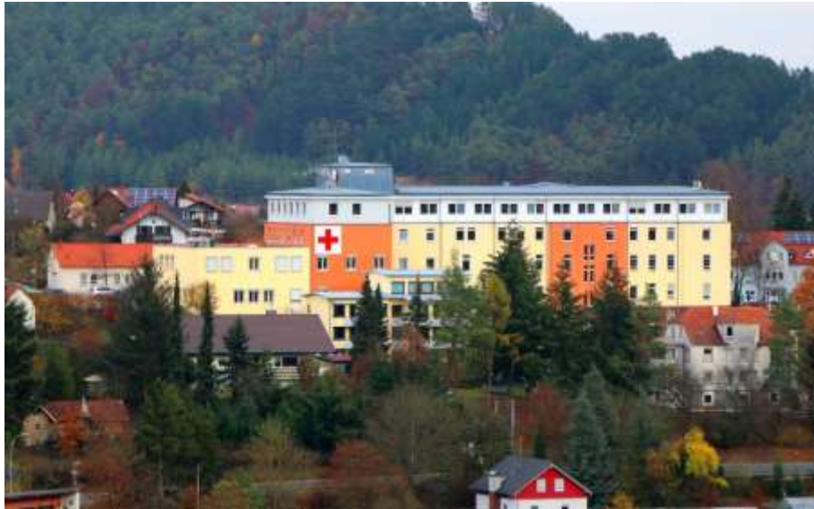
Vier Millionen Euro investiert der Krankenhausverband Hardheim-Walldürn in die Erweiterung des Krankenhauses. Foto: Rüdiger Busch
