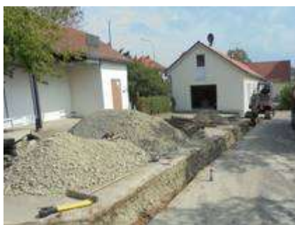
Mit der Neuverlegung von Leitungen sind die Arbeiten am Krankenhaus gestartet. Foto: Rüdiger Busch
